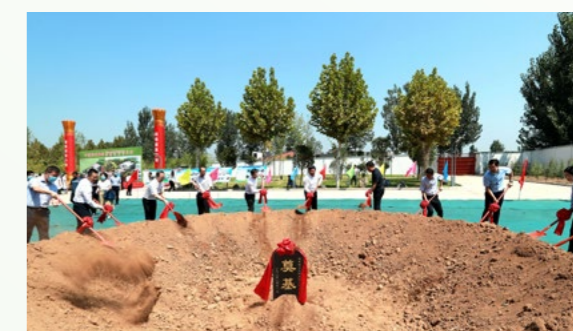
▲ 莲庄镇卫生院传染病门诊综合楼奠基仪式
